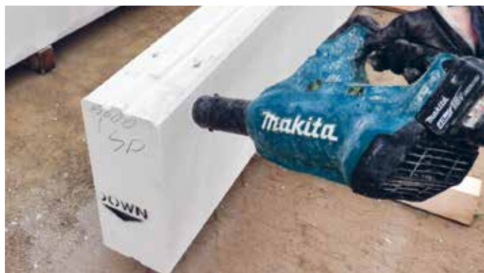
Rengör elementets yta från filspån efter fräsning
