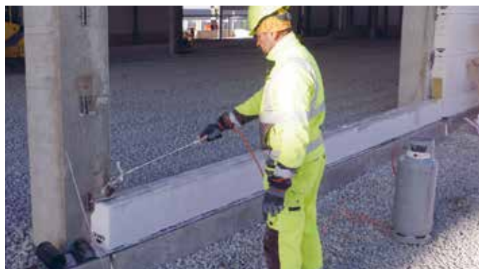
En yta som är täckt av frost måste värmas upp före limning
