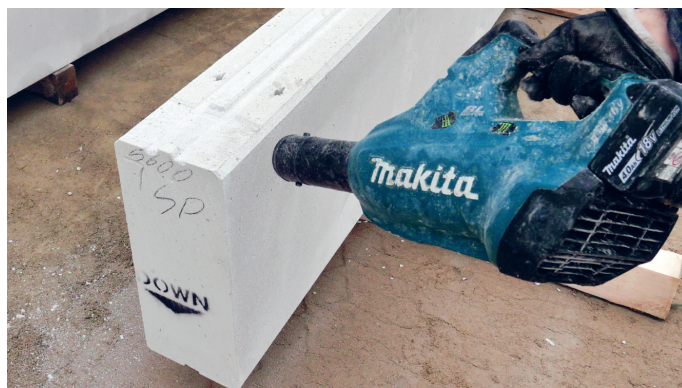
Rengör elementets yta från filspån efter fräsning
