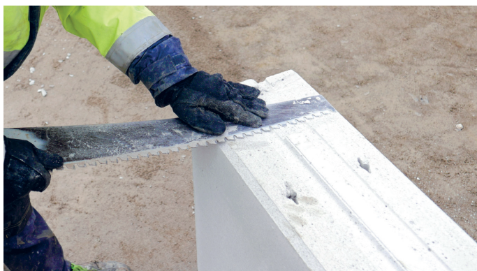
Fräsning av hål för att fästa fästankaret
