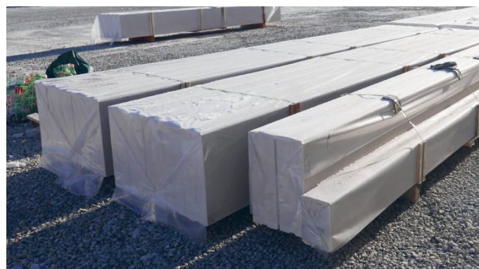
Elementen på byggsplatsen bör skyddas från nederbörd
